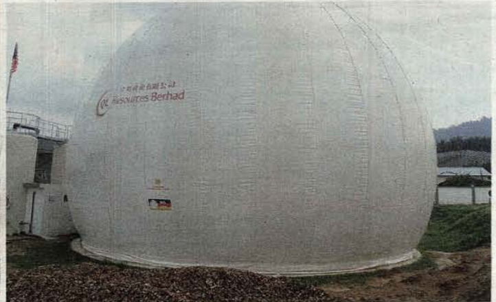
SFERA ini digunakan sebagai tangki penyimpanan biogas sama seperti fungsi tangki gas LPG NGV.
